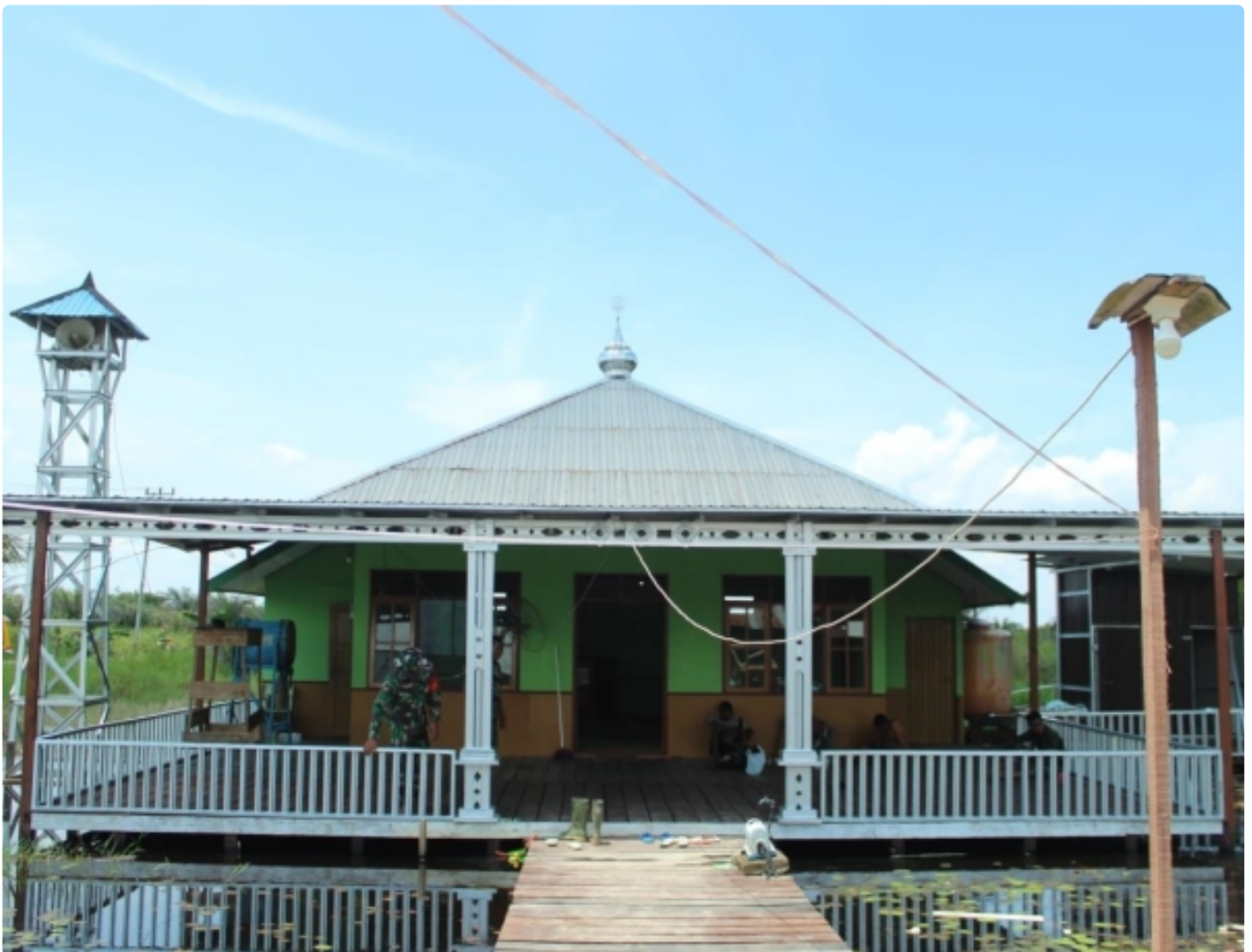
Sasaran fisik TMMD 115 Rehab Masjid Jami' Al Hidayah Rampung 100 Persen
